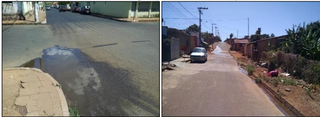
Figura 3.34 – Problemas de drenagem pela ausência de dispositivos instalados.
