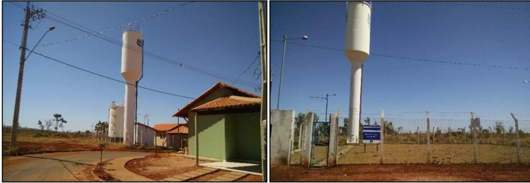
Figura 3.28 - Reservatórios do Sistema de Abastecimento de Água.
