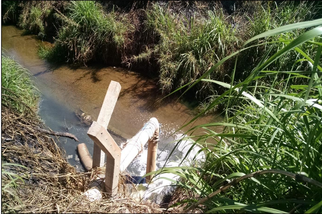
Figura 3.32 – Ponto de lançamento de efluente doméstico tratado – Ribeirão São Francisco do Borja.
